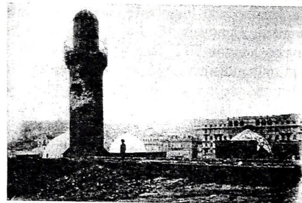
Şəkil 3. Şah məscidinin top atəşinin təsirinə uğrayaraq dağıdılmış hissəsinin şərq tərəfdən görünüşü
