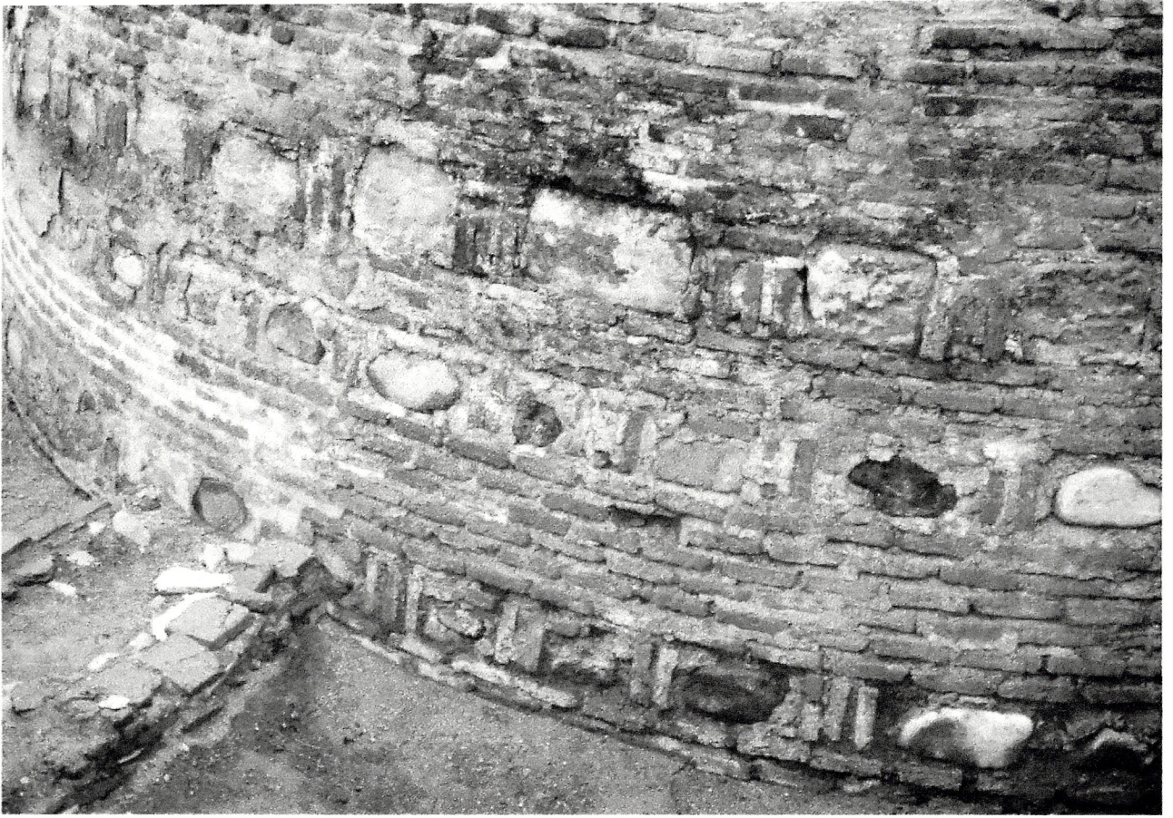
Şəkil 2 Narınqalanın cənub divarındakı bürcün hörgüsü.
