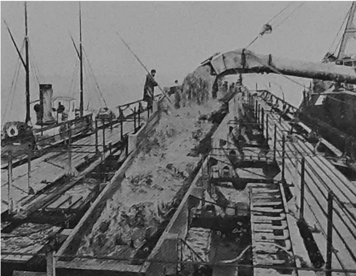
Работа по засыпке Биби-Эйбатской бухты. Фотография публикуется впервые
