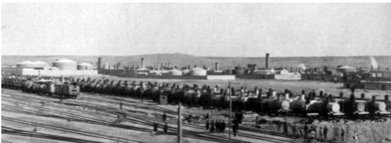
Нефтяной терминал и железнодорожная станция близ Баку. 1902 г. Фотография публикуется впервые
