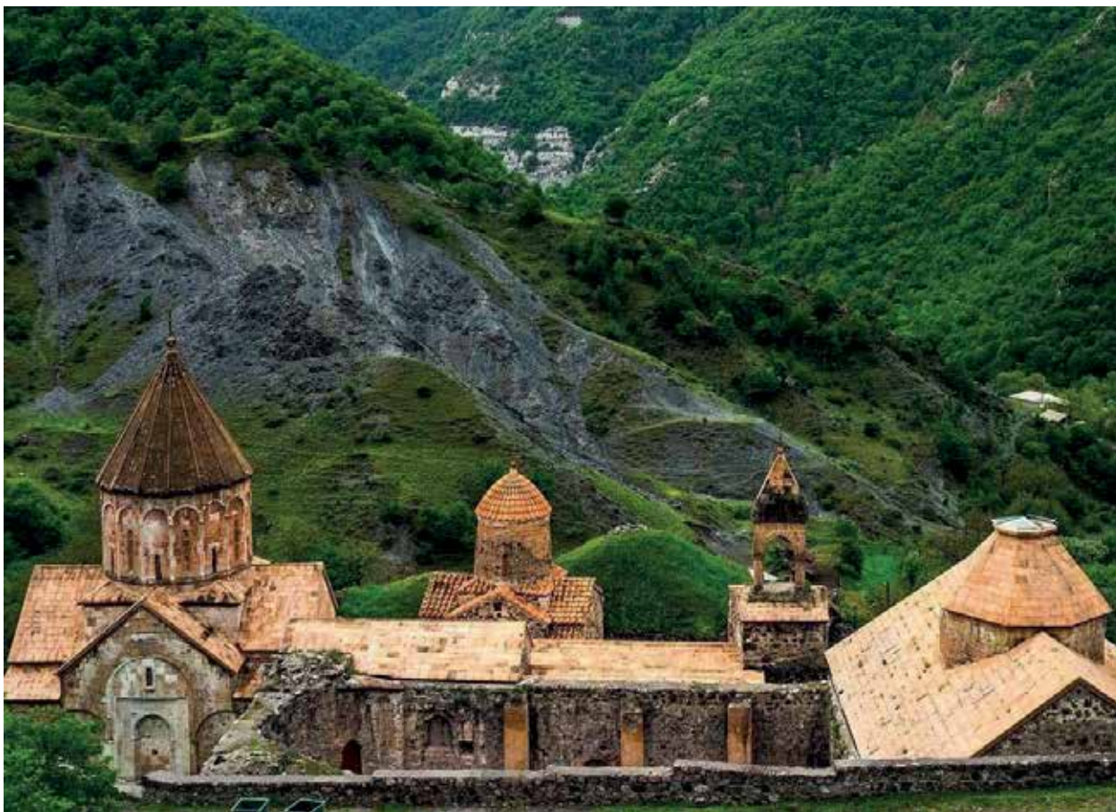
Худавенкский монастырь. Заметны результаты реставрационных работ, проведенных с использованием привезенного со стороны строительного камня
