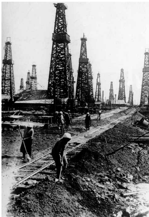
Строительство узкоколейной железной дороги на нефтепромысле им. 26 Бакинских комиссаров. Баку, 1935 г.
