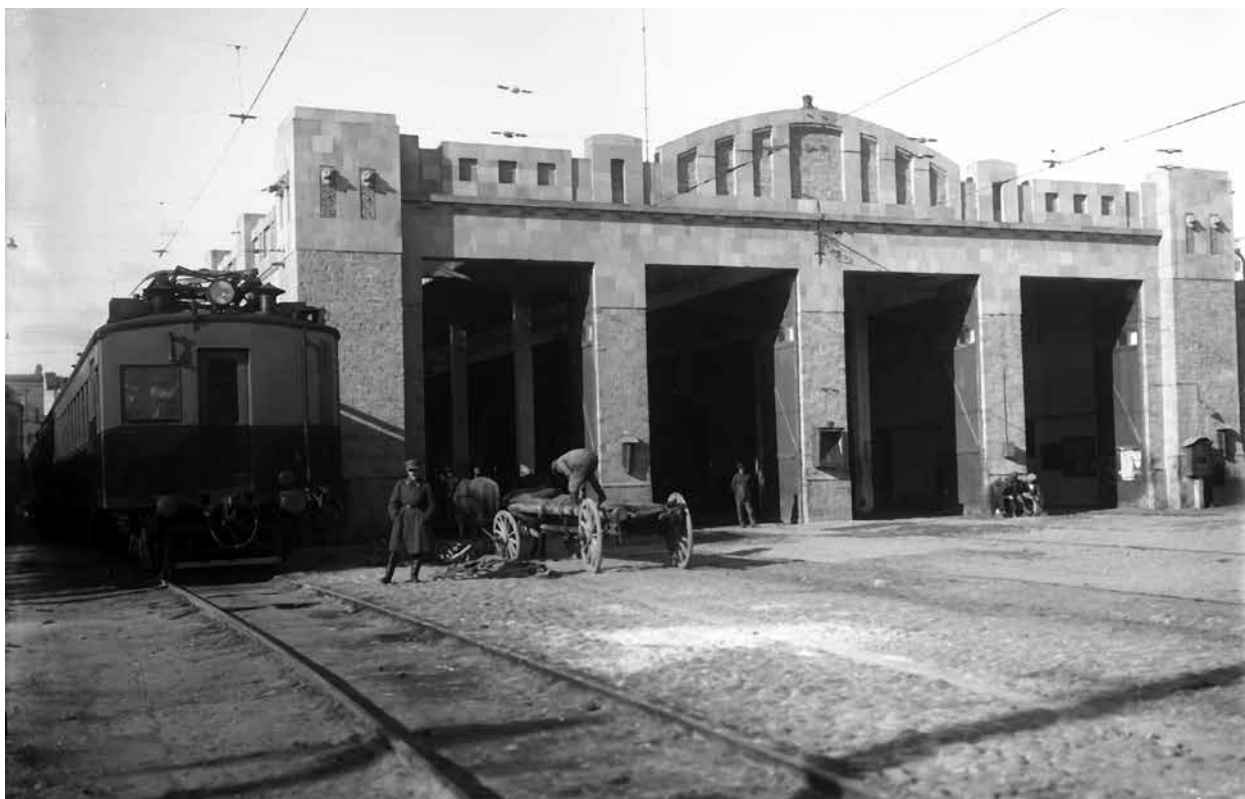
Электрическое депо электрифицированной железной дороги. Баку, 1934 г.
