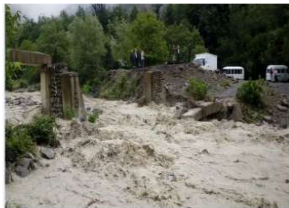
Şəkill. Laysan eroziyası zamanı yaranan daşqın
