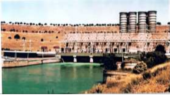
Şəkil 1. Mingəçevir SES-nin görünüşü. 1955
