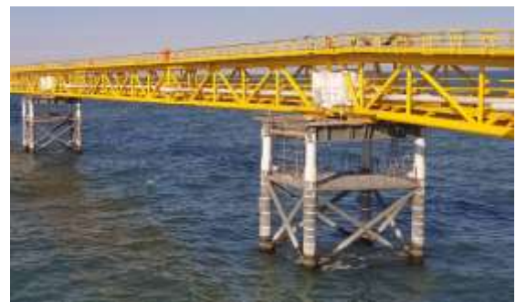
Şəkil 4. Yeni estakada körpüsünün dayaq bloku üzərində oturməsi
