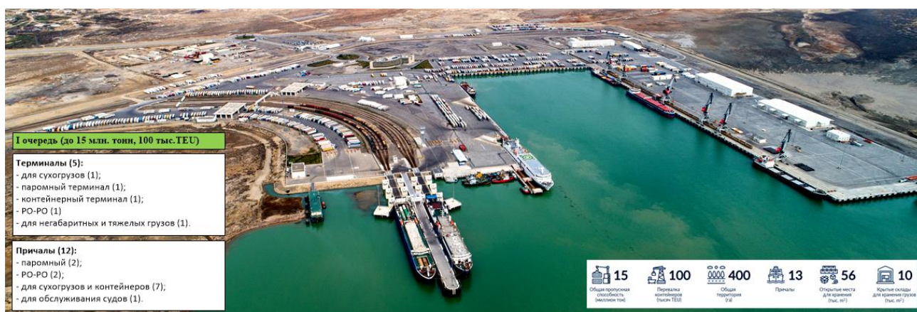
Рис. 3. Текущее состояние I очереди строительства Бакинского порта
