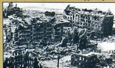
Разрушения на освобождённых территориях
