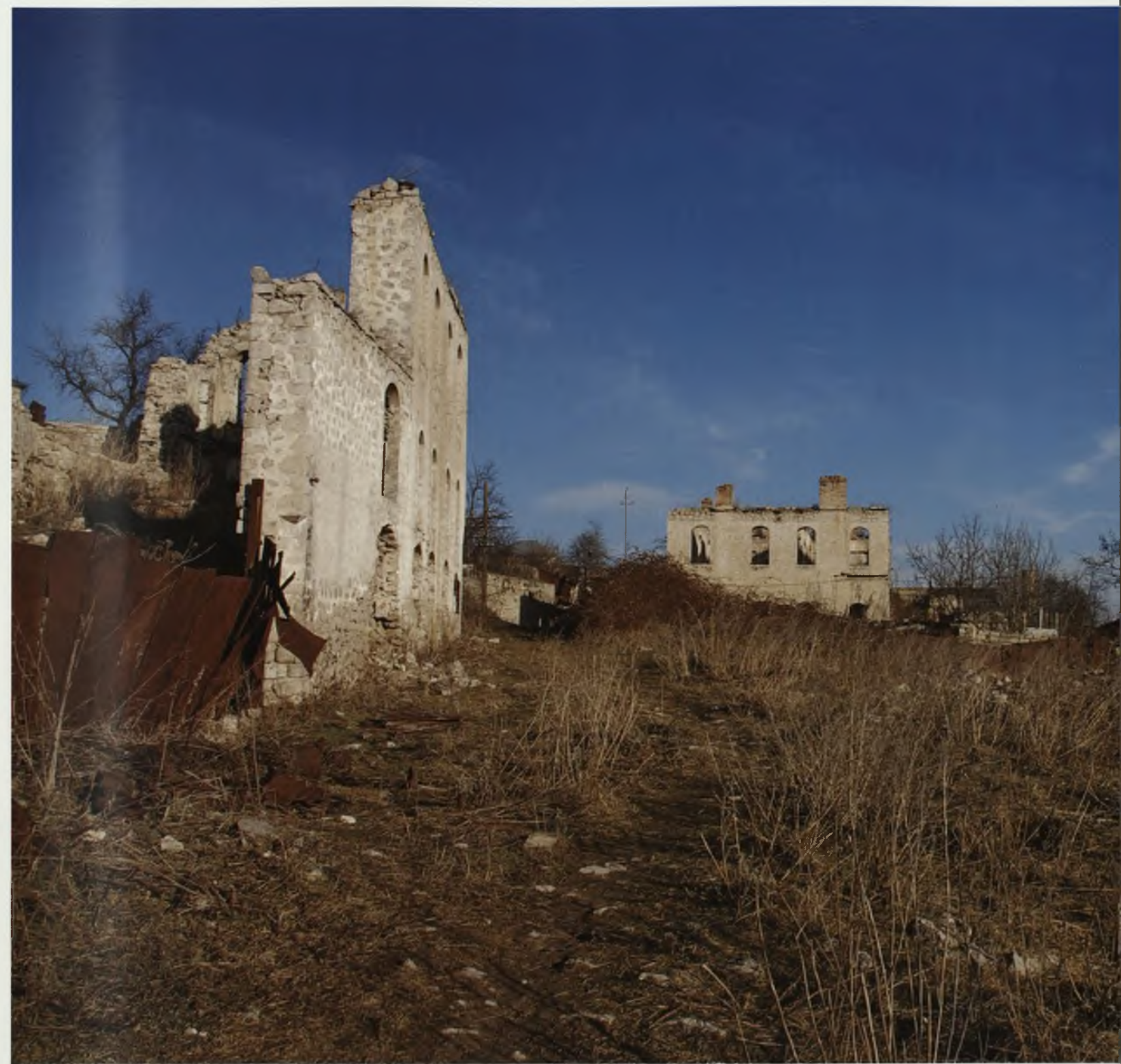
Şuşa. Dağıdılmış evlər Shusha. Destroyed houses Шуша. Разрушенные дома
