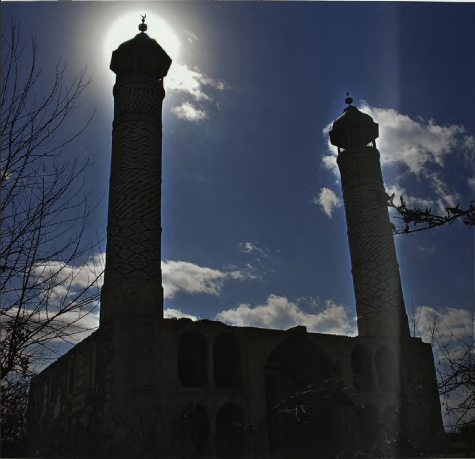
Ağdam. Dağıdılmış məscid Agdam. Destroyed mosque Агдам. Разрушенная мечеть
