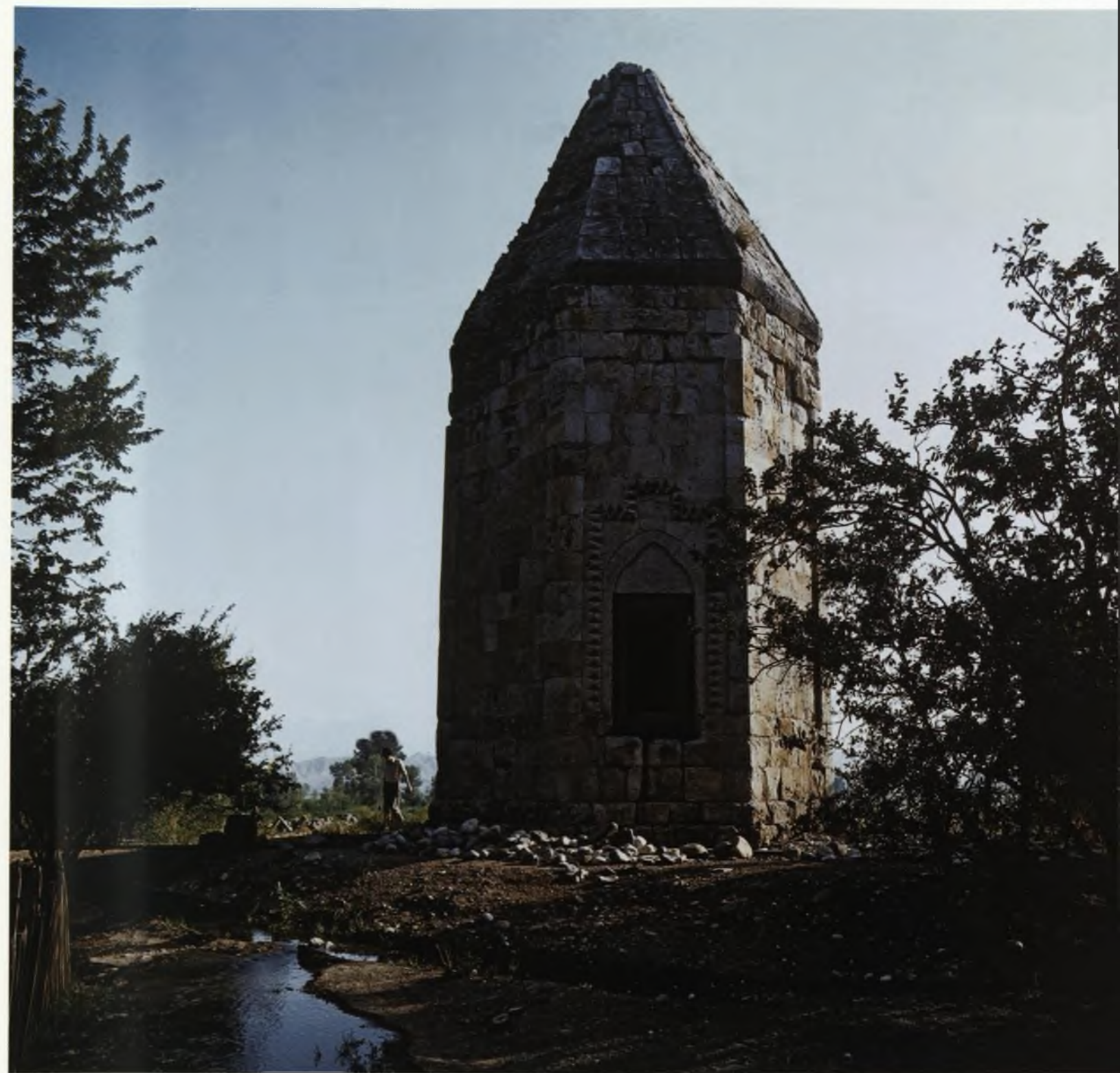
Səkkizguşəli Xacə Yəhya türbəsi. Məmmədbəyli kəndi. 1304-1305-ci il Octahedral Mausoleum of Haja Yahya. Mamedbeyli village. 1304-1305 Восьмиугольный мавзолей Хаджа Яхья. Село Мамедбейли. 1304-1305 годы
