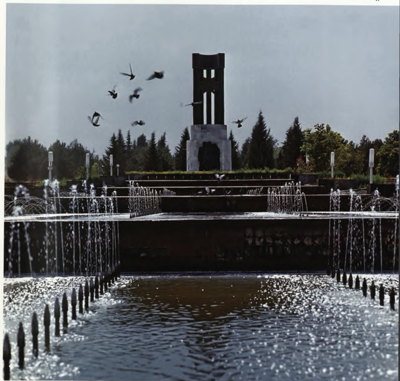
1941-1945-ci illər Böyük Vətən Müharibəsində həlak olanların xatirəsinə ucaldılan abidə Memorial to the dead in Great Patriotic War of 1941-1945 Мемориал павшим в Великой Отечественной Войне 1941-1945 годах
