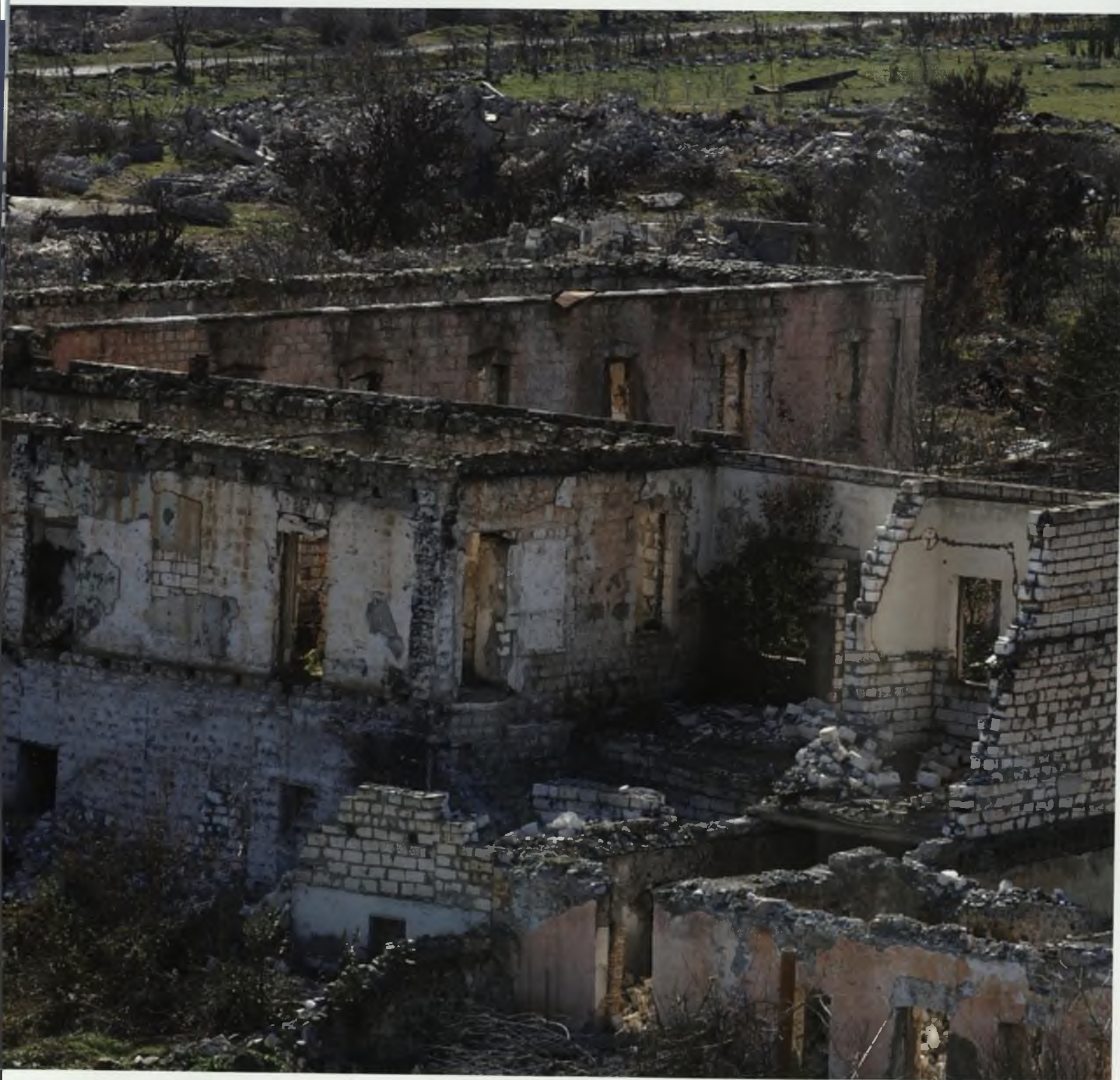
Ağdam. Dağıntılar Ağdam. Destructions Агдам. Разрушения
