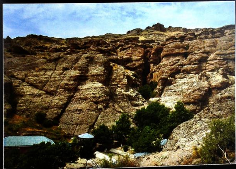
Dağ süxurlarının bütöçlüyünü pozan tektonik çatlak.
