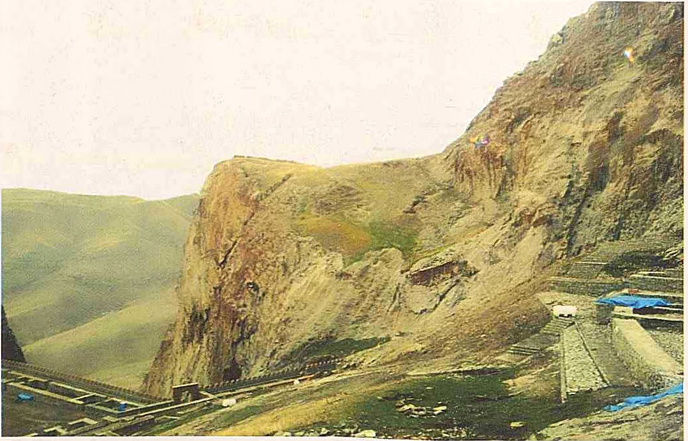
Şəkil 23. Əlinəcəqalanın mərkəzi hissəsində təmir işləri. Рисунок 23. Реставрационные работы в центральной части Алинджагалы. Picture 23. Restoration work in the central part of Alinjagala.
