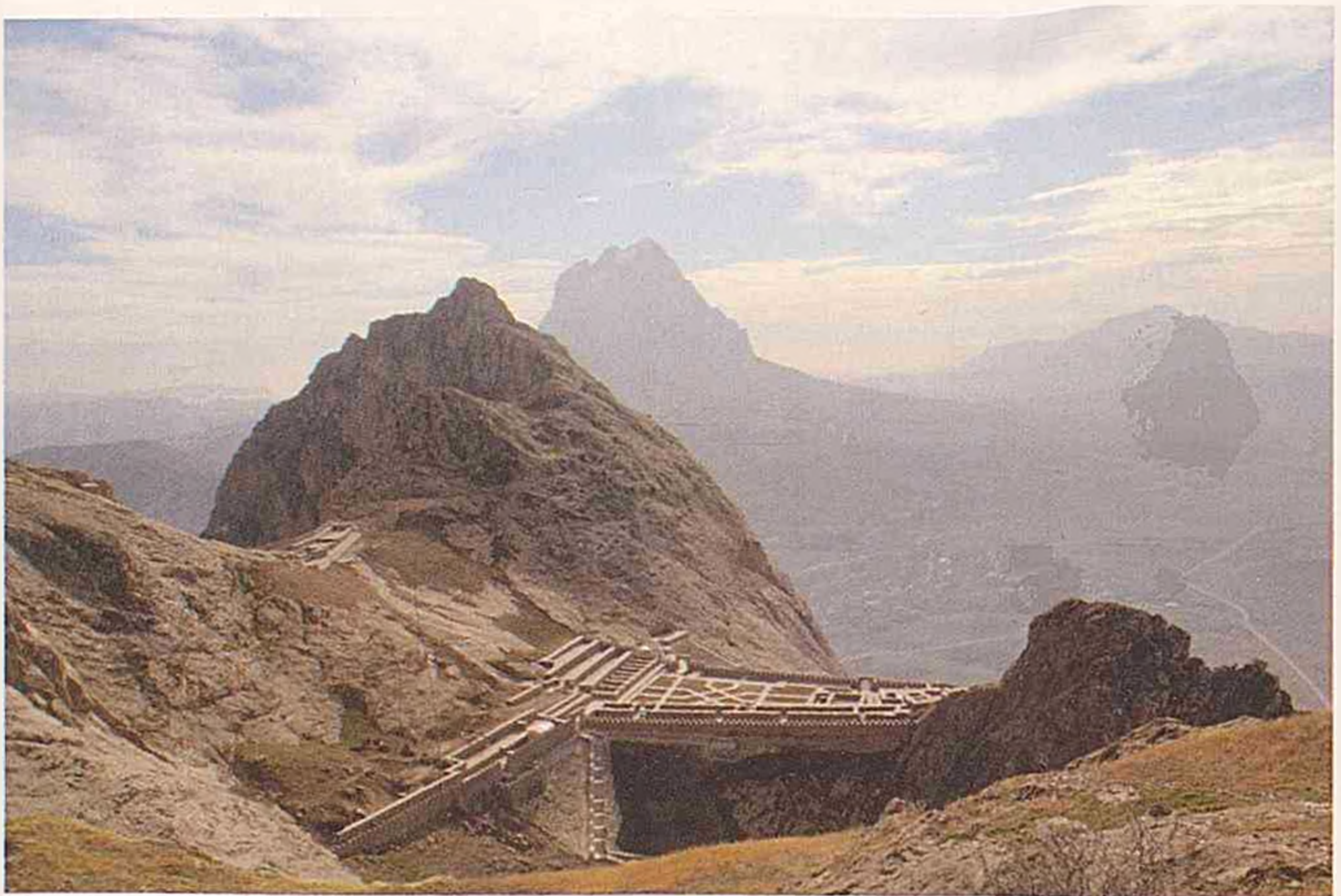
Şəkil 29. Əlincəqala bəgradan sonra. Рисунок 29. Алинджагала после реставрации. Picture 29. Alinjagala after the restoration.
