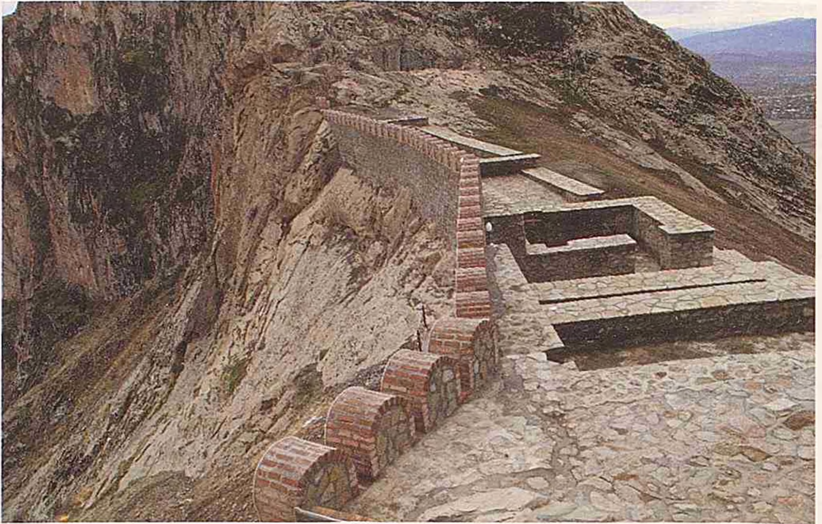
Şəkil 30. Qalanın şərq divarları bərpadan sonra. Рисунок 30. Восточные ворота крепости после реставрации. Picture 30. The eastern fortress gate after the restoration.
