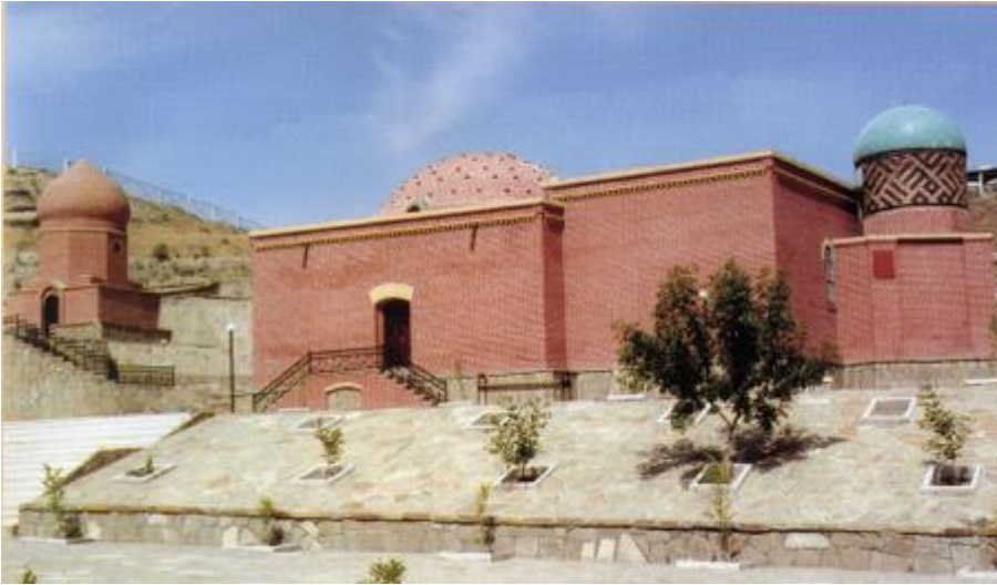
Şəkil 126. İmamzadə kompleksinin cənubdan görünüşü.
