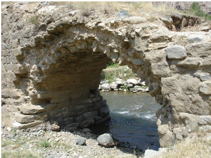
Şəkil 133. Beş aşırımlı Biləv körpüsü.
