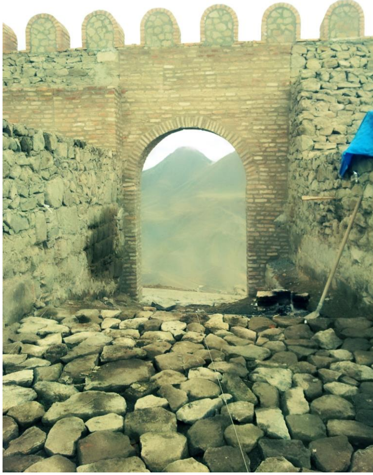
Şəkil 81. Əlincəqalanının şərq qapısı bərpa zamanı.
