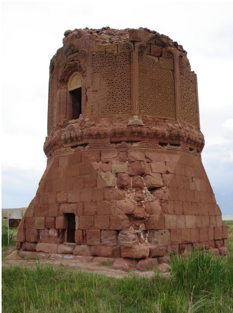
Şəkil 105. Gülüstan türbəsi bərpadan əvvəl.
