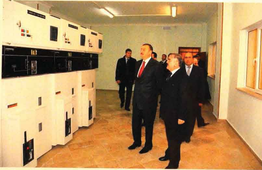
Naxçıvan modul tipli elektrik stansiyasının açılış mərasimi. 20.12.2006.
