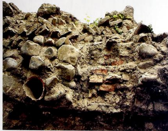
Binanın altından keçən borunun qərbdən görünüşü The western view of the pipe beneath the building
