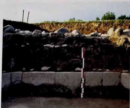
Hovuzun iç divarlarının hörgüsü The inner wall masonry of the pond
