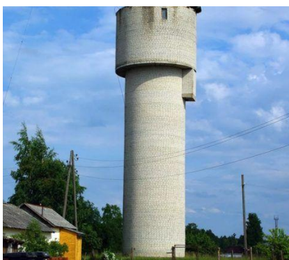
Şəkil 4.9. Kərpicdən tikilmiş su qülləsi
