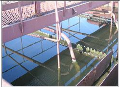
Şəkil 10.44. Minsk AS-ın aerotekində çirkab su axınının sonuncu (üçüncü) pilləsi
