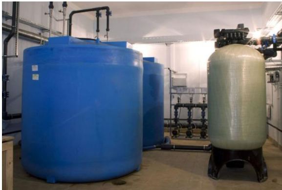
Şəkil 4.5. Lokal sutəmizləyici qurğu
