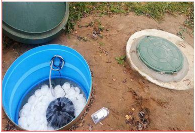
Şəkil 10.37. Əldəqayırma bioloji filtr
