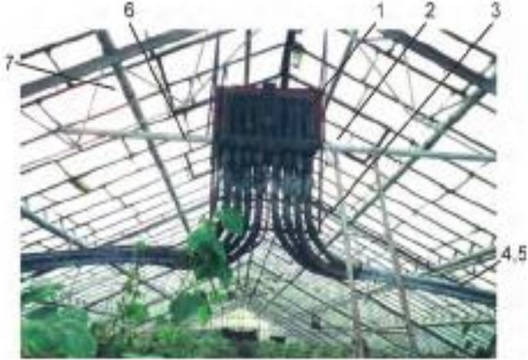
Şəkil 5.40. Anqar tipli istixanada suyun verilməsinin avtomatlaşdırılmış paylayıcı qovşağı
