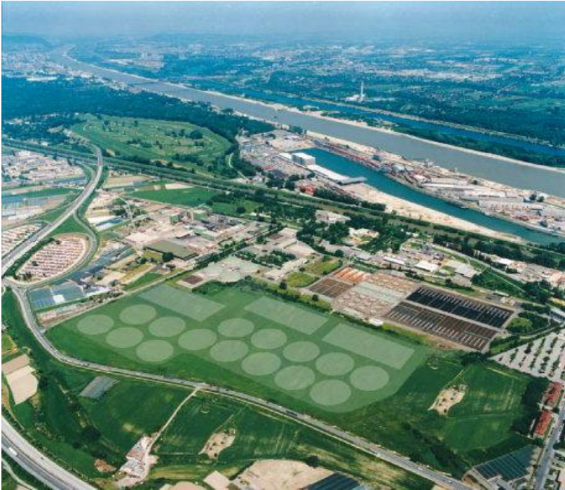
Şəkil 12.19. Vyana şəhərinin çirkab sularının təmizləyici baş stansiyası
