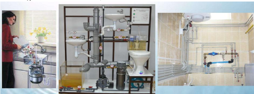
Şəkil 4.18. Binadaxili sanitar-texniki qurğular sistemi
