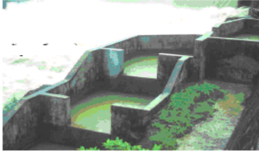
Şəkil 6.9. Pilləli balıq yolları
