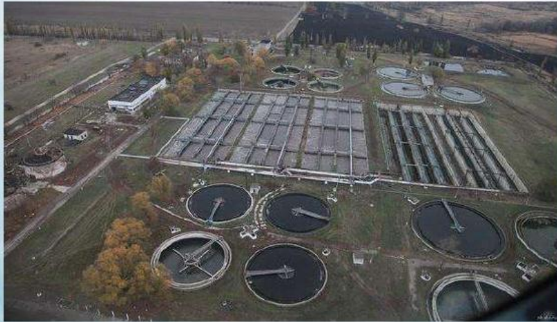
Şəkil 10.6. Çirkab sularının təmizlənməsinin texnologiyasının xarici görünüşü
