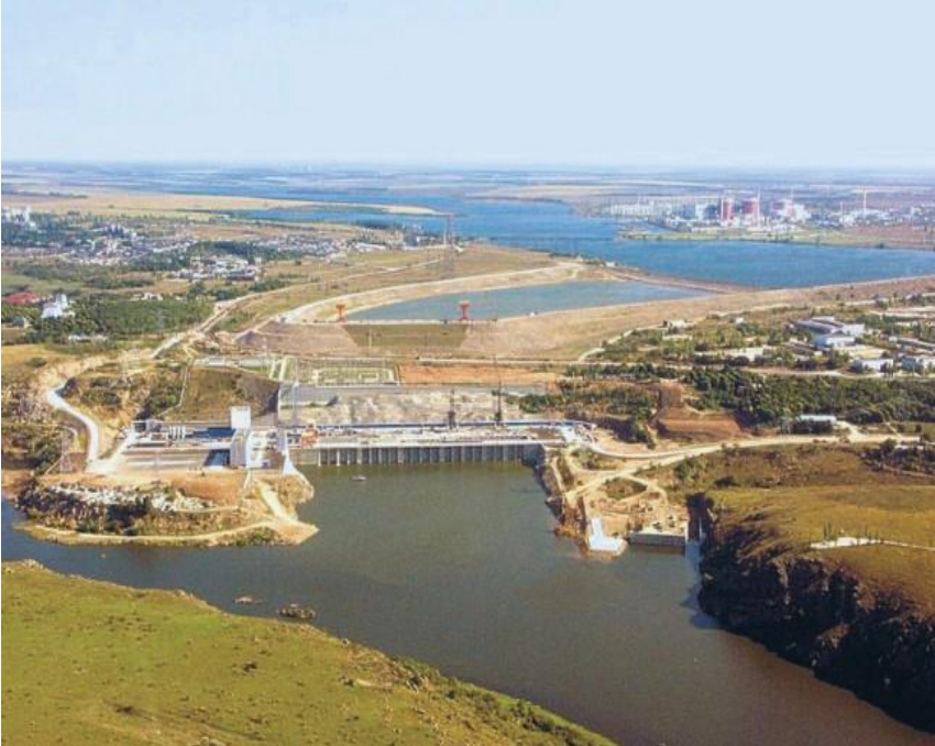
Şəkil 3.28. Cənubi-Ukrayna AES-i ilə birlikdə enerji kompleksi yaradan Taşlıq HSES-in panoraması
