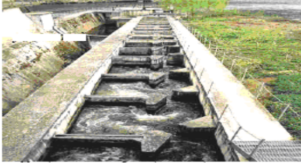
Şəkil 6.8. Artırılmış kələ-kötürlüklü balıq yolları
