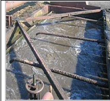
Şəkil 10.43. Minsk AS-ın aerotekində çirkab su axınının birinci pilləsi
