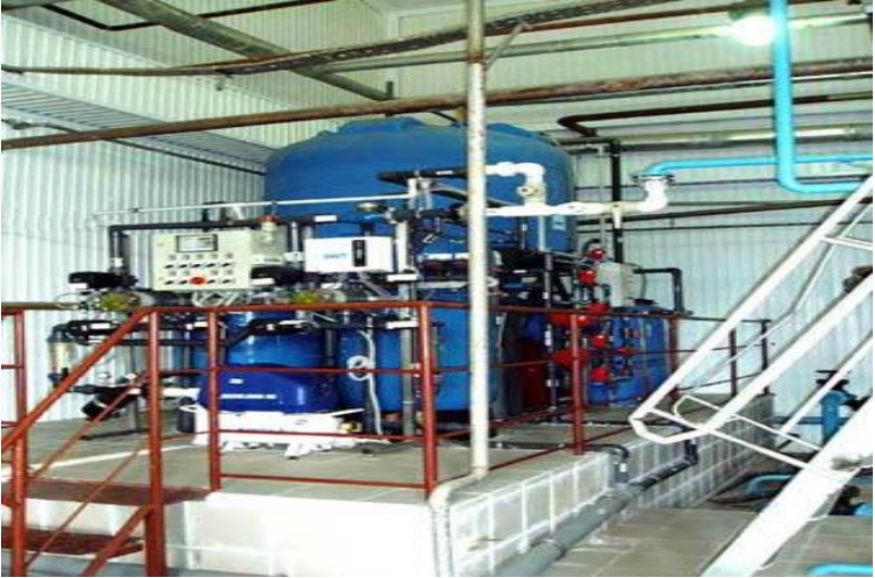
Şəkil 3.18. İon mübadilələri texnologiyası əsasında suyun codluğunun yumşaldılmasının tam avtomatlaşdırılmış qurğusu
